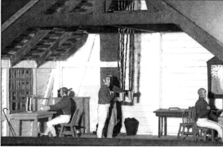
الشكل 1-5 نموذج عن محطة تليفراف مصراع، من الداخل في معسكر بلاندفورد (تقدمة متحف الهيئة الملكية لسلاح الاتصالات، بلاندفورد)
